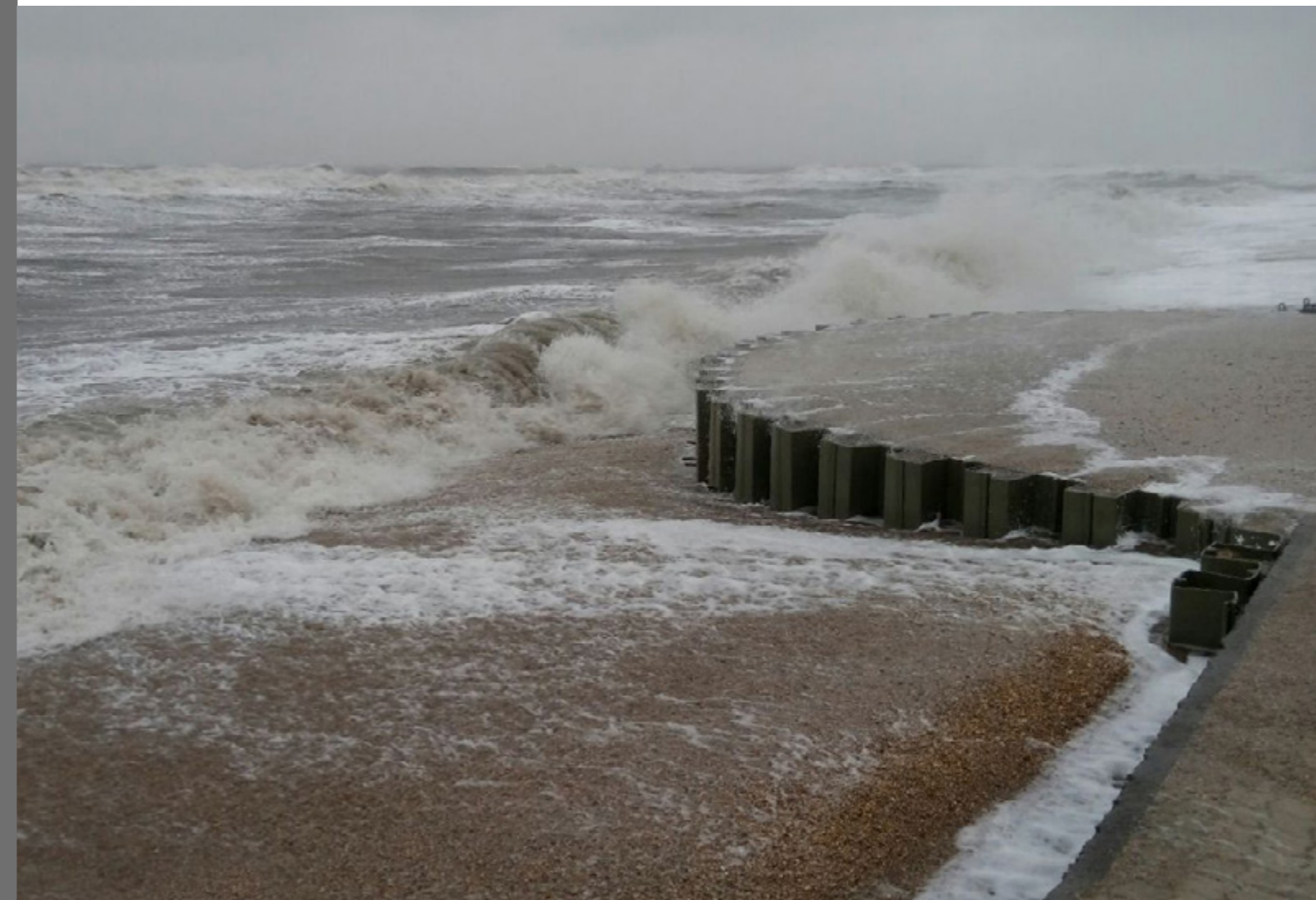
Wykorzystanie grodzic kompozytowych do budowy ścian oporowych.
